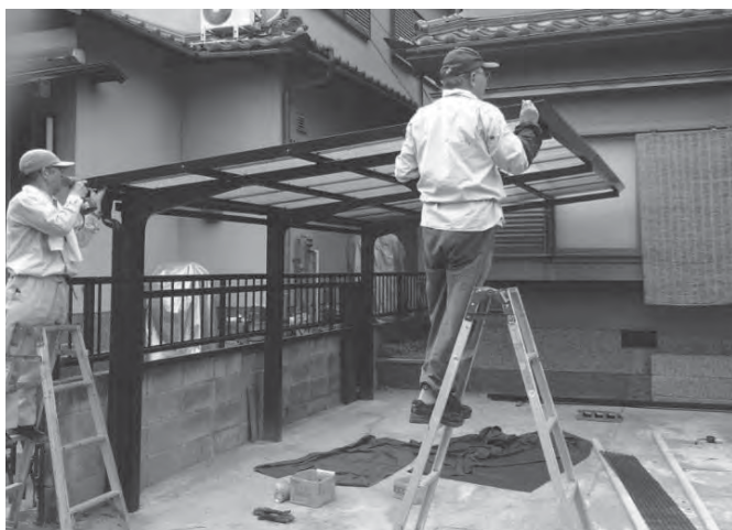
↑ 個人依頼に対応してガレージ波板取替と塗装
