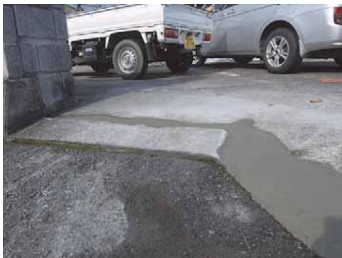
↑ 外部土間の補修(段差無し)
