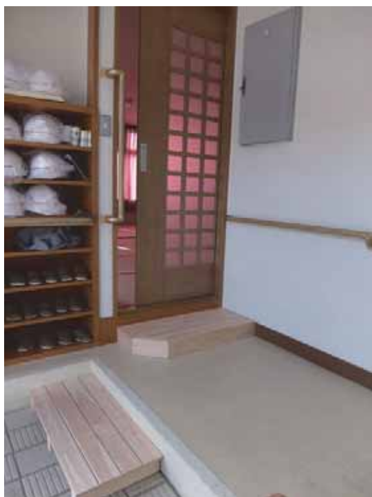
↑ 玄関の踏み台・手摺設置
