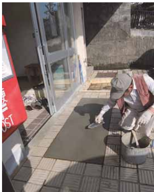
↑ ポーチの沓脱場の補修(段差無し)
