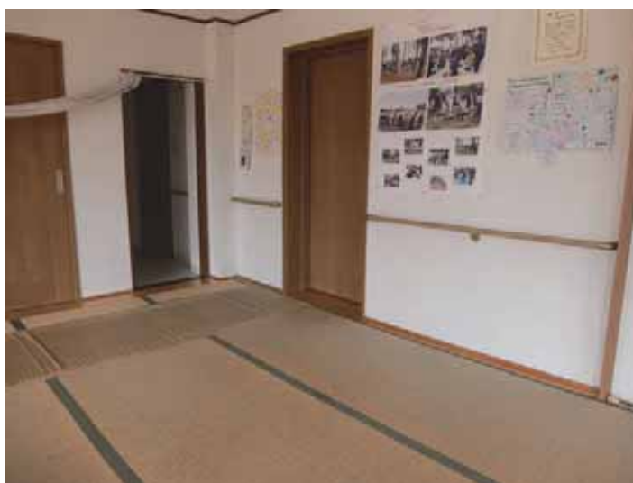
↑ 大広間の手摺設置(トイレへの動線)
