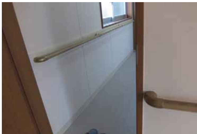
↑トイレの手摺設置
