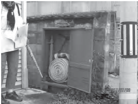
ホース格納庫の点検
