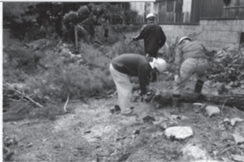
高齢者支援 敷地内 樹木伐採・片付
