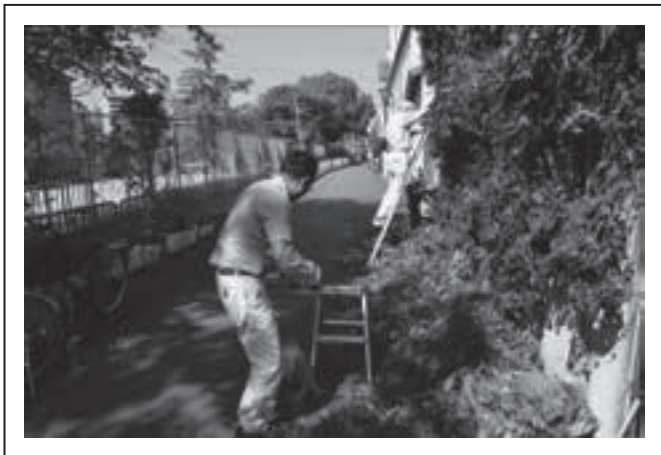
(写真左) 壁を伝うツタの剪定作業中のスタッフ
